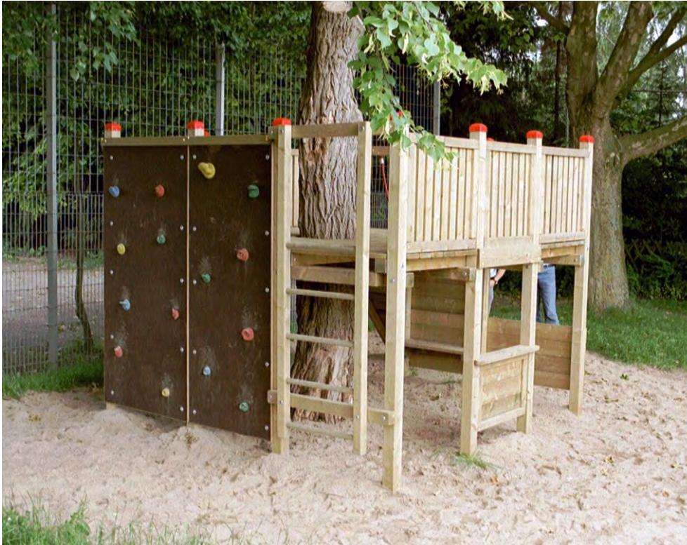
Durch unsere besondere Konstruktion wird eine Verletzung des Wurzelwerks weitgehendst vermieden, die Bodenbretter werden bei der Montage auf den Umfang des Stammes angepaßt. Stammdurchmesser bis 1,00 m möglich.
